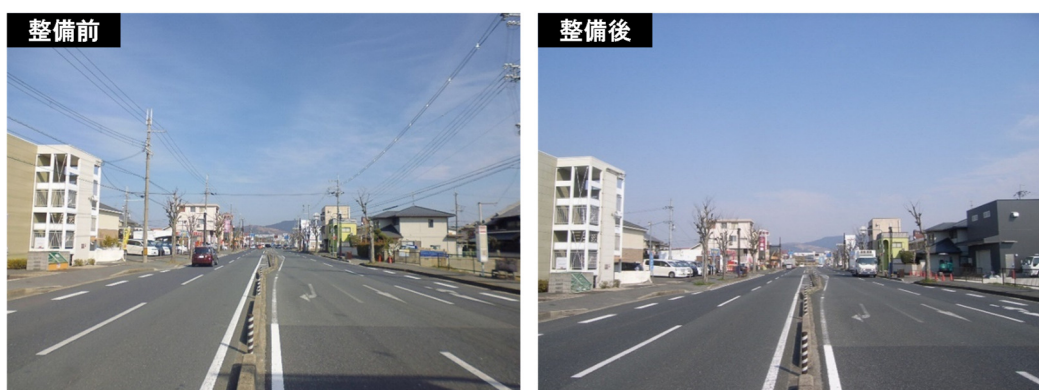
「防災」の観点に基づく無電柱化の整備事例（奈良生駒線（大宮通り））
