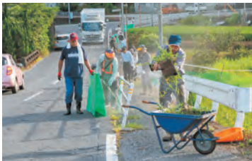
背丈ほども伸びるとい路肩の雑草を清掃
