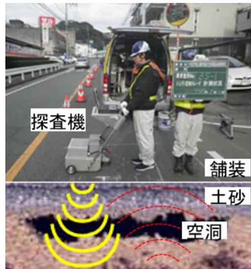
図-12 二次調査(探査機によるレーダ調査の様子)
