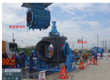
図 5-2 設置前の切替弁と切断した既設管
