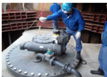
図 7-1 切替弁を操作する様子
