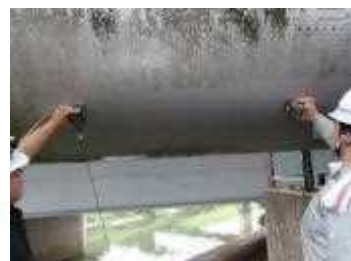
図 7-3 周辺管路の流速を計る様子
