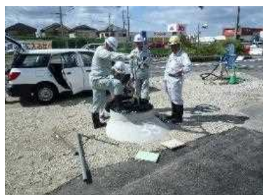
図 6-1 洗管時の制水弁を操作する様子
