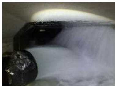
図 6-2 洗管時の排泥管らボックスカルバートへ排水する様子
