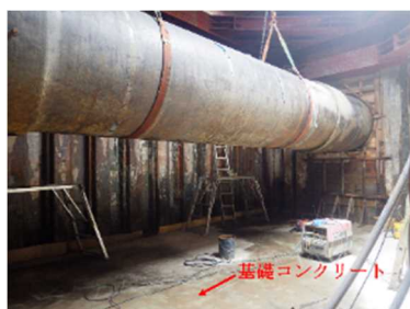
図 5-1 切替弁設置前の既設管φ1500mm
