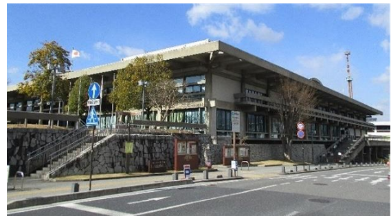
図1 改修前の外観(南東側)
