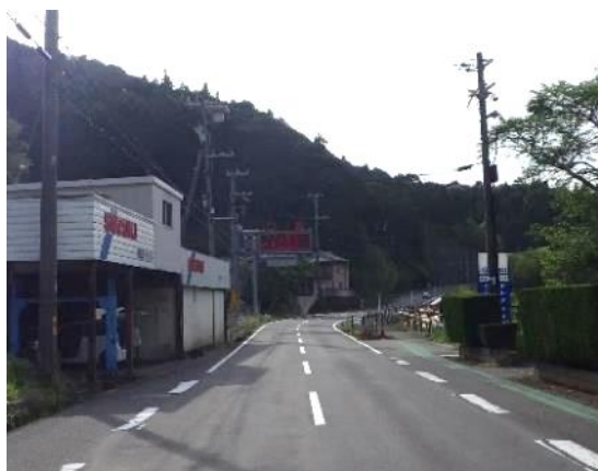
図7. 三重県での通行止め案内 （三重県熊野市小阪地内）
