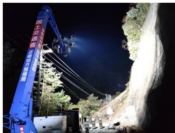
図8. 照明車を用いた夜間法面 監視の様子
