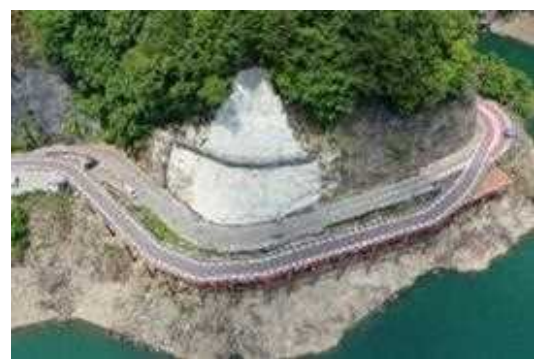
図4. 仮橋完成(令和6年6月21日撮影)
