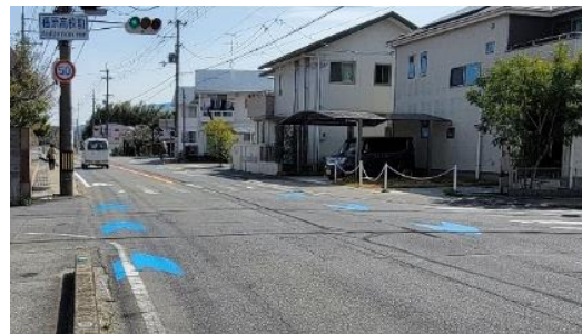
▲自転車通行空間（車道混在）
