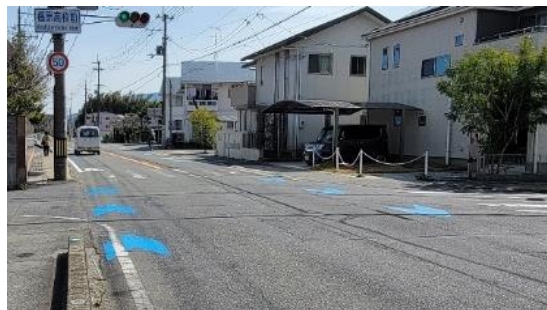
▼県道戸毛久米線（橿原市）の整備後の状況
