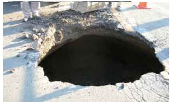
図 2-6 管渠の劣化による道路陥没に関する参考資料 3
