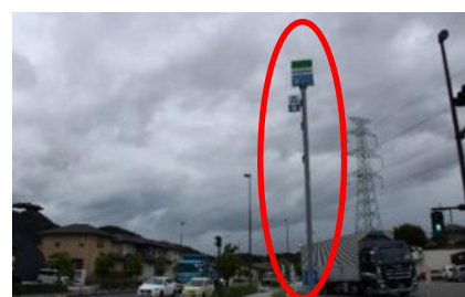
広告物の修景前（R1.6撮影）
