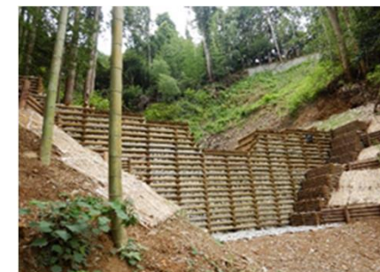
谷止工(公共事業への間伐材利用)
