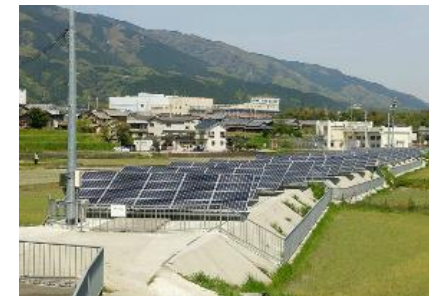
農業用水路を活用した太陽光発電施設
