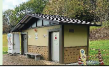
トイレの整備
