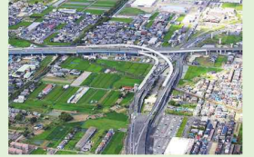
(仮称) 橿原 J C T (大阪方面接続ランプ)【令和8年春供用】
