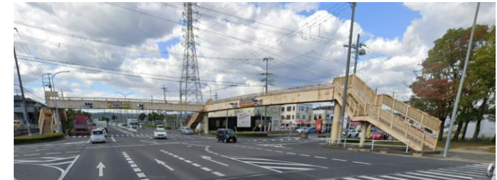
▲真美ヶ丘1号横断歩道橋 写真 [Googleストリートビュー引用]
