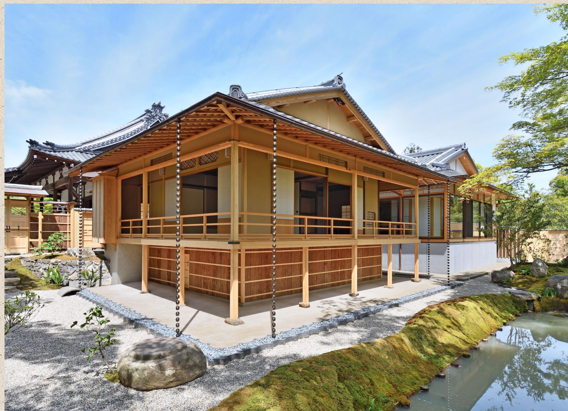
東大寺指図堂本堂庫裡改修工事2023年(令和5年)竣工
