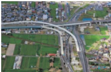
〈仮称〉橿原JCT(大阪方面接続ランプ)【令和8年春供用】
