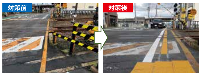
▲視覚障害者誘導標示設置（国道169号 桜井市谷）
