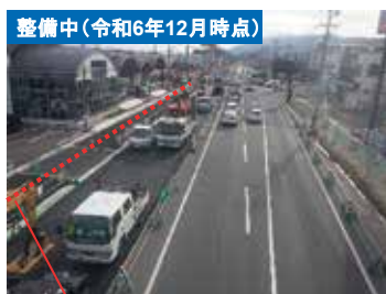
既存ストック埋設箇所
