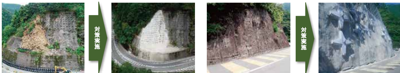
▲法面对策（国道168号 十津川村野尻）
