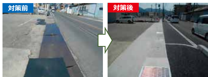
▲歩道設置（国道166号 葛城市尺土）
