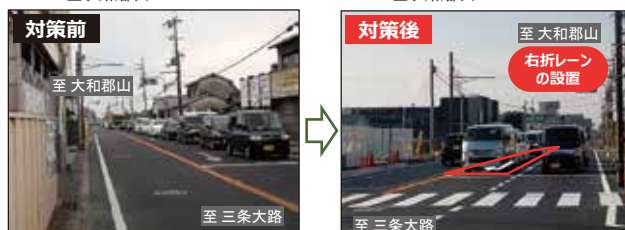
用地買収を行い、右折レーンを設置
