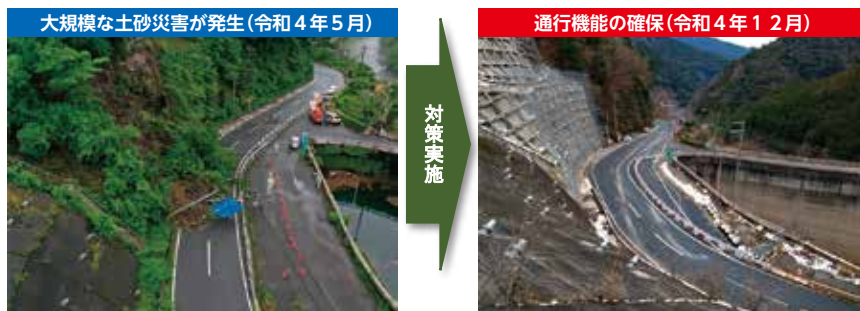
▲法面对策による通行機能の確保（国道169号 川上村大迫）
