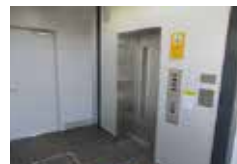
エレベーター設置 〔平城駅〕
