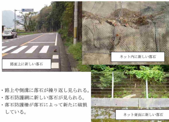
道路巡回での着目点(1)：路上や落石防護柵に新しい落石
