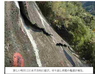
道路パトロールでの着目点(5)：吹付の亀裂・剥落
