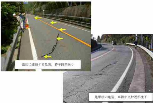
道路パトロールでの着目点(1)：路面の亀裂・沈下
