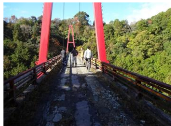
両エリアをつなぐ橋
