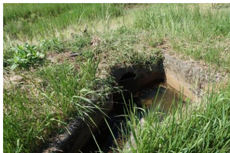
写真3 東エリア内の水路、排水樹
