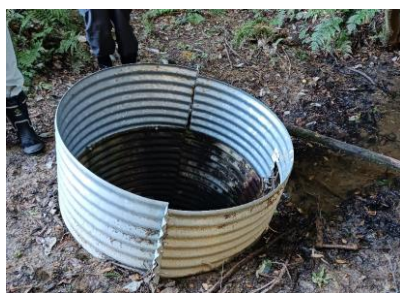
写真4 西エリア内の横断管の流入口
