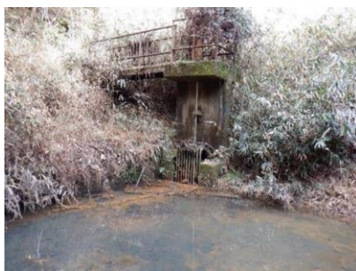
写真1 東エリア内の横断管の流入口
