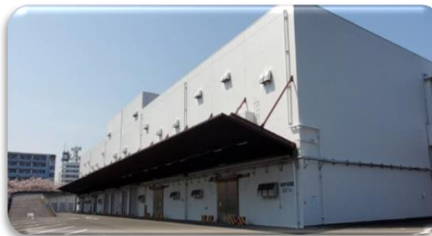
立川防災合同庁舎備蓄倉庫棟（東京都立川市）
