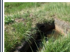
写真3 東エリア内の水路、排水柵
