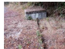
写真2 東エリア内の横断管の流入口(排水樹)
