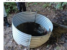
写真4 西エリア内の横断管の流入口
