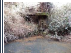
写真1 東エリア内の横断管の流入口
