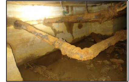
〈内部給水管：劣化・漏水〉
