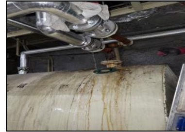
〈内部給水管：劣化・漏水〉
