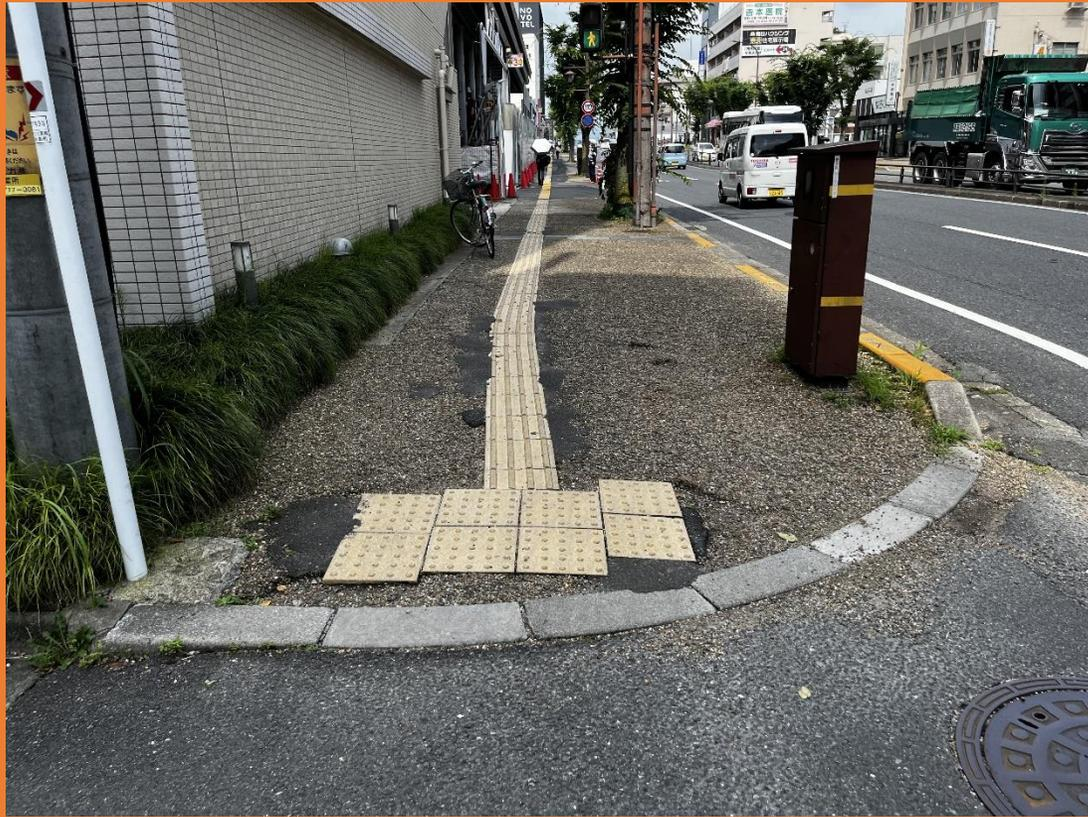
舗装の損傷が著しい段階
