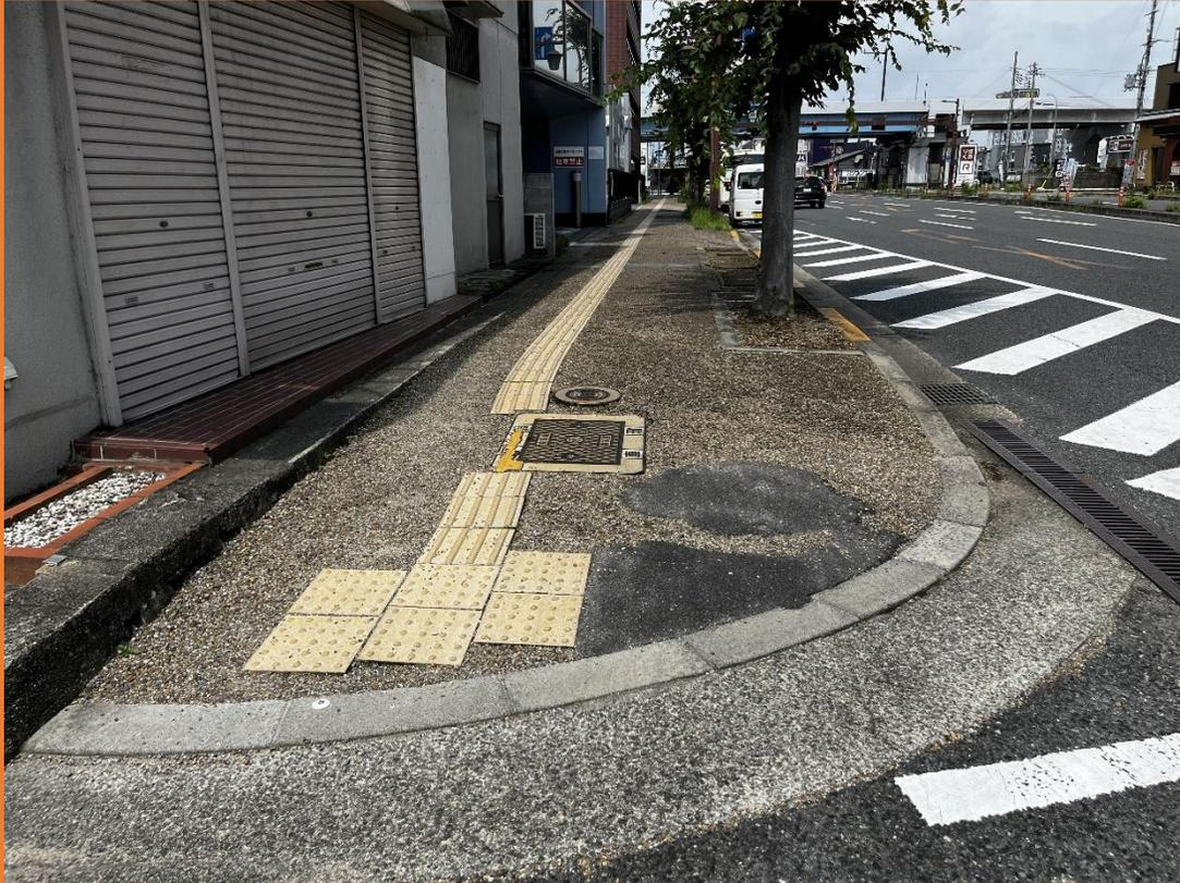
舗装の損傷が著しい段階
