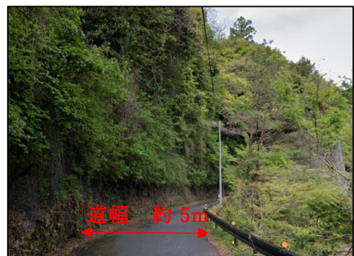
図 2 施工現場周辺の様子
