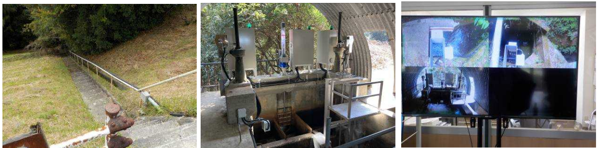
写真2-開閉ゲートまでの階段、遠隔操作システム、遠隔操作システム画像
