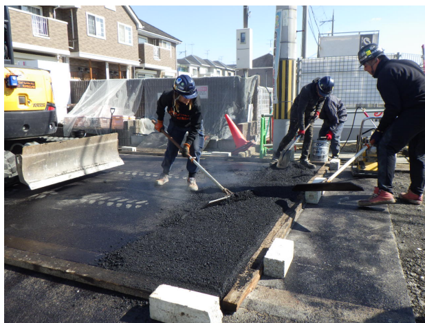
写真-2 平坦部の施工
