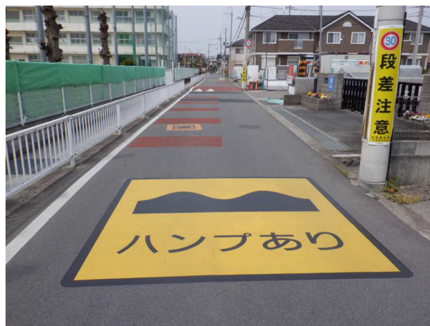
写真7 ハンプ完成の遠景
