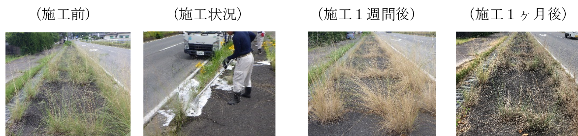
写真 4 新技術による除草作業の経過状況
