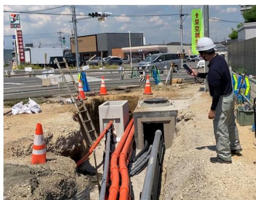
図-3 実際の点群データ取得風景
