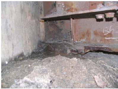
図25 主桁01の損傷 腐食「d」
