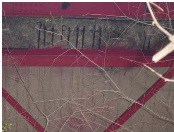
図12 床版の鉄筋露出
