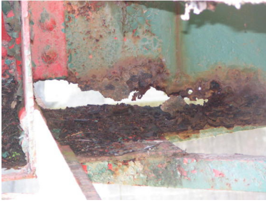
図8 鋼桁の腐食
