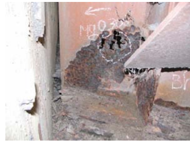
図26 主桁03の損傷 腐食「d」
