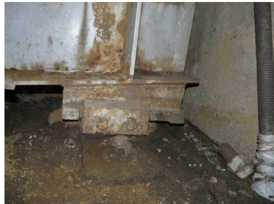
図11 支承の機能障害
