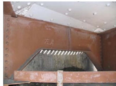
図28 横桁01の損傷 腐食「a」
