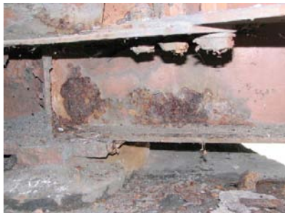
図27 主桁04の損傷 腐食「d」
