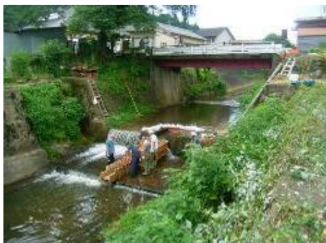
魚道設置実験 (宇陀川 宇陀市大宇陀区)
