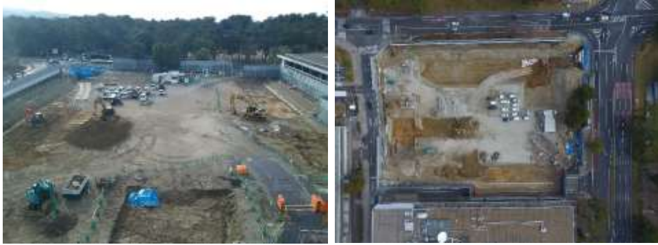
図 2.21 工事状況（平成 28 年 12 月 2 日現在）
