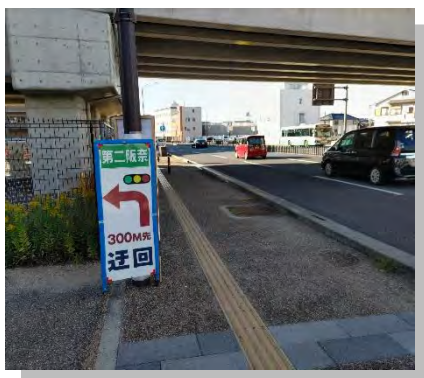
図 6-16 迂回誘導看板の設置
