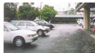
(透水性舗装・斑鳩町役場)
