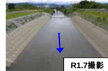
(三宅) 出屋敷西橋より上流 (改修済み)
