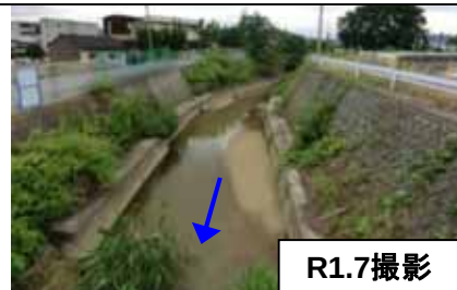
(檀原) 檀原橋より上流 (未改修区間)
