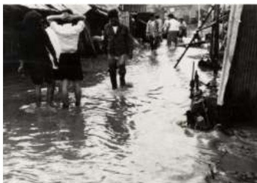
昭和34年9月伊勢湾台風による被害状況 (五條市本町)
