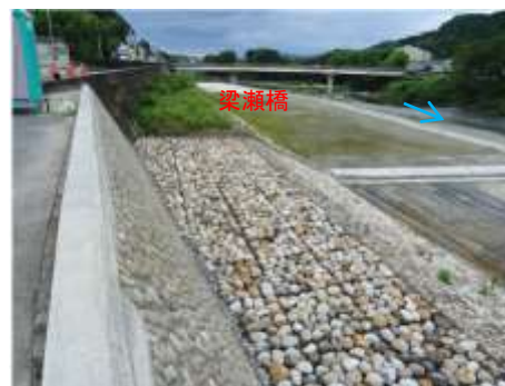
梁瀬橋下流 (改修済み区間)
