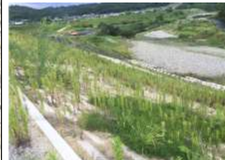
70km付近右岸(改修済み区間)
