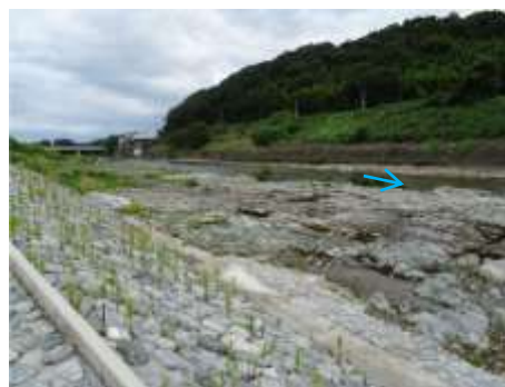
72km付近 (改修済み区間)
