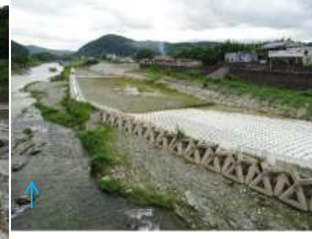
梁瀬橋下流 (改修済み区間)
