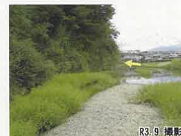
②76.0k付近左岸(76km付近、未改修)
