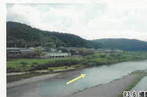
②美吉野橋下流左岸付近(79km付近、未改修)
