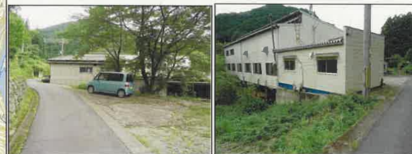
宮滝大橋付近左岸(未改修区間)
