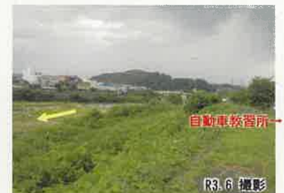
②73.7k付近左岸 (73.7km付近、未改修)
