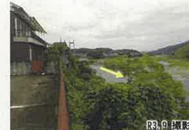
①75.2k付近右岸(75.2km付近、未改修)
