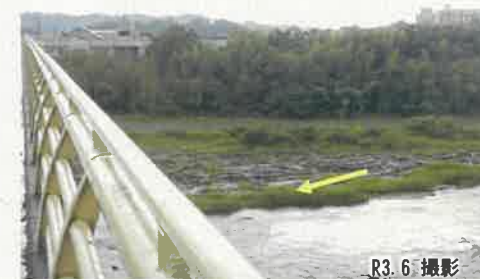
千石橋右岸(未改修区間)
