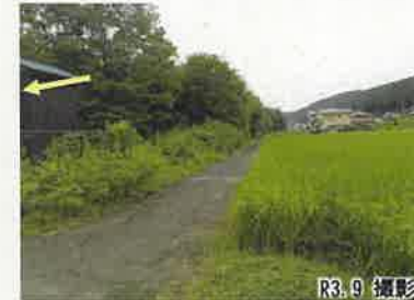
③76.0k付近左岸(76km付近、未改修)
