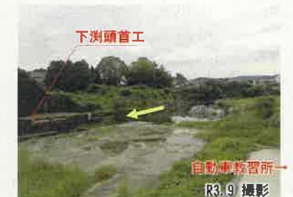
①73.6k付近上流 (73.6km付近、未改修)
