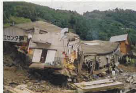
平成2年9月台風19号による被害状況 (川上村東川)
