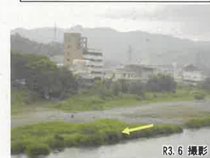
74.7k付近右岸(未改修区間)
