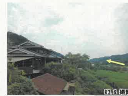
①美吉野橋下流左岸付近(79km付近、未改修)
