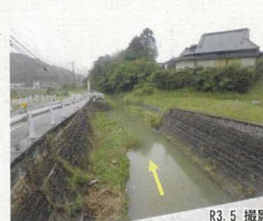
③両谷橋下流 (1.2km付近、改修済)
