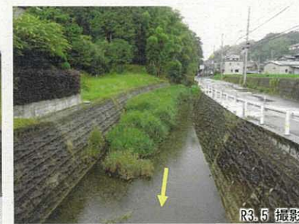
③両谷橋上流 (1.2km付近、改修済)
