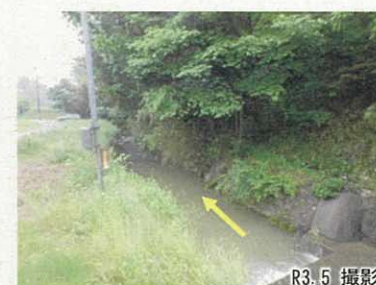
②両谷橋下流付近 (1.2km付近、未改修)
