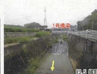
①整備下流端橋梁上流 (0.8km付近、改修済)
