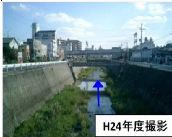
②奈良工区 (改修後)
