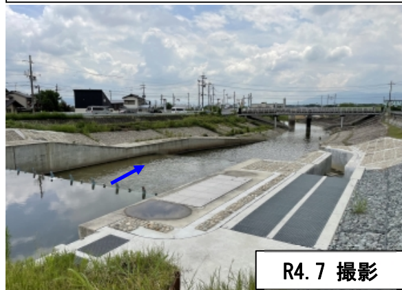
①安堵工区 (改修後)
