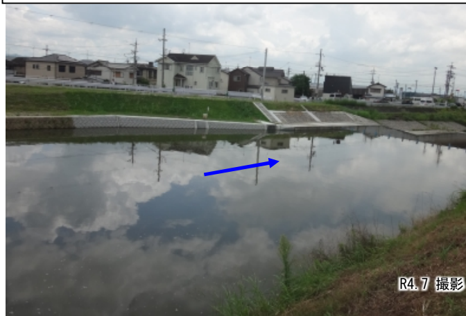
②西安堵井堰上流 (1.5km付近、左岸のみ改修済)
