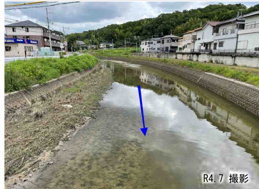
② 小瀬工区（災害復旧区間）
