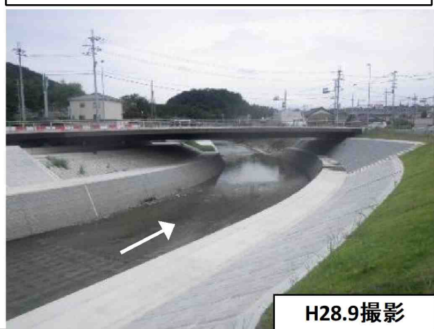
① 斑鳩工区（改修後）
