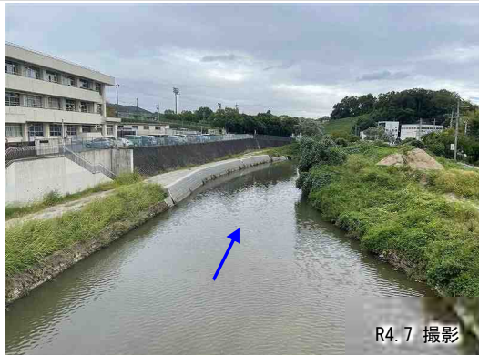
① 小瀬工区（護岸改修済、片岸のみ）
