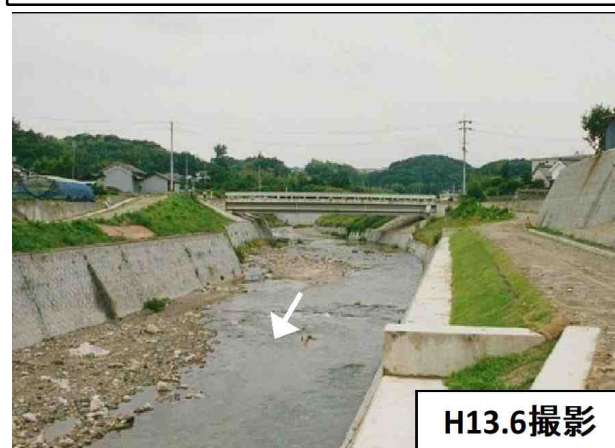
② 梨本工区（改修後）
