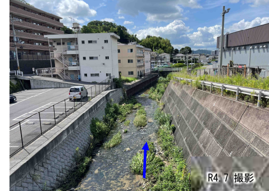
③ 生駒工区（改修済み区間）
