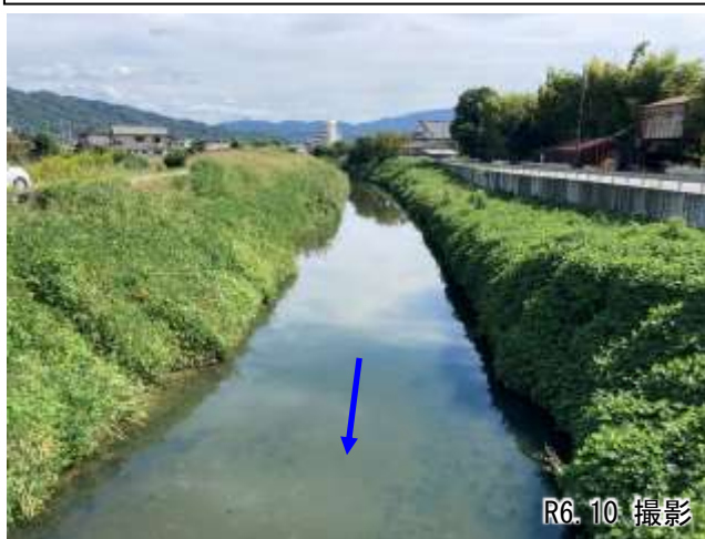
①庚申橋上流 (10.0km付近、未整備)
