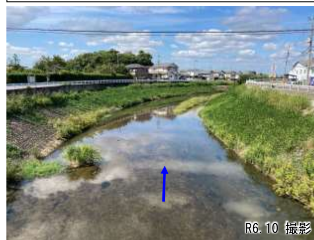
②庚申橋下流 (10.0km付近、改修済み)
