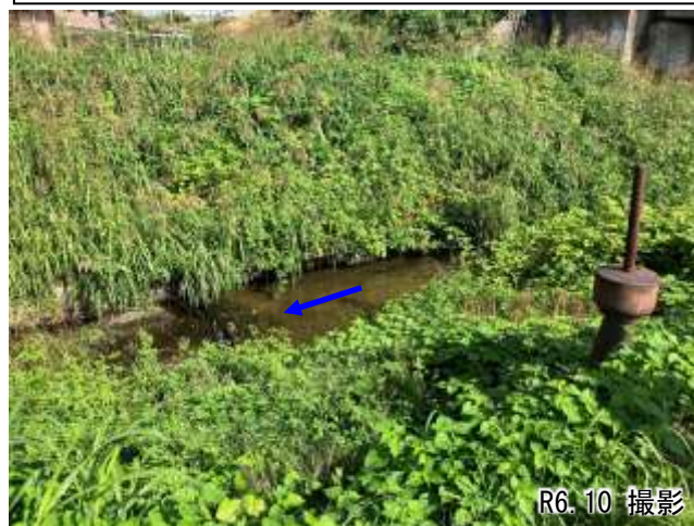
②5号井堰 (3.9km付近、未改修)
