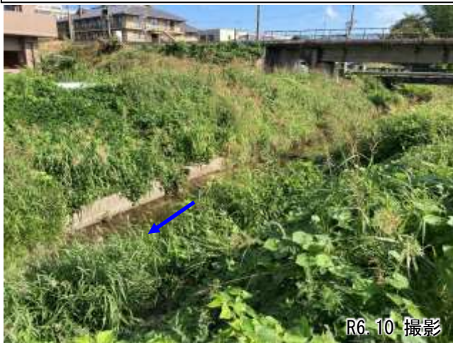
①5号井堰下流 (3.9km付近、改修済み上流端)
