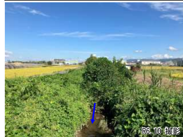
③天理市道（乙木合場線）より上流 (2.0km付近、未改修)
