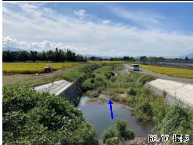
②天理市道（乙木合場線）より下流 (2.0km付近、改修済み)
