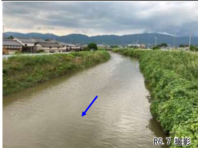
①吉田橋上流 (0.1km付近、改修済み)
