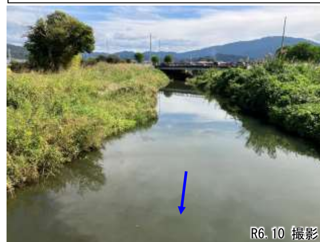
②佛生橋下流 (12.4km付近、未改修)
