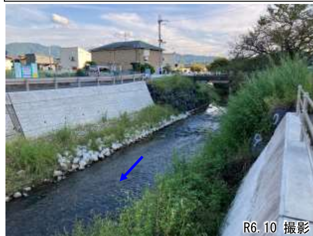
②極楽橋上流 (2.7km付近、整備中)
