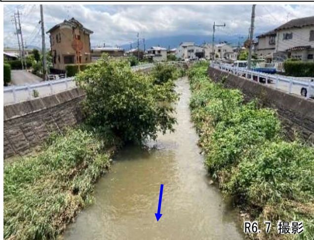
①耳成橋上流 (2.5km付近、整備済み)
