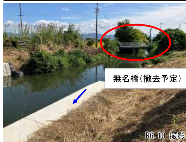
②逆流防止樋門上流 (0.0km付近、整備中)
