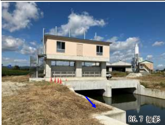
①逆流防止樋門 (0.0km付近、整備中)
