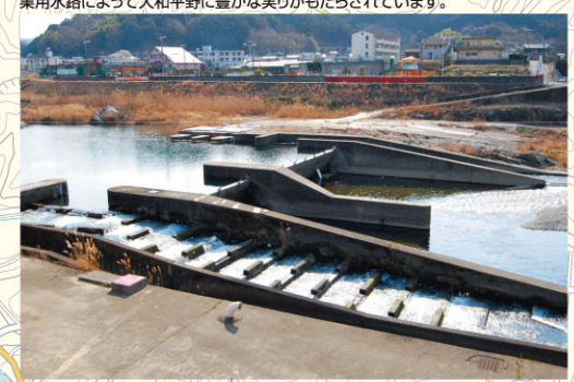
下淵頭首工 この施設から農業用水と水道水が取水されています。ここから全長約330kmの農業用水路によって大和野平に豊かな水がもたらされています。
