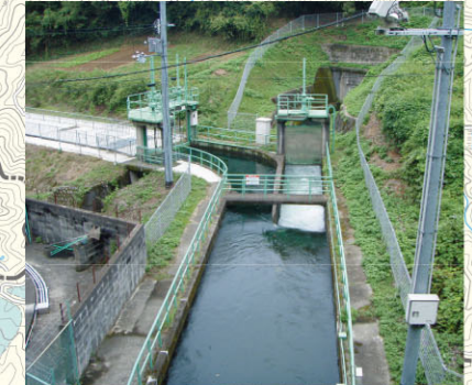
東西分水工 下淵頭首工から取水された水がここで姿を現し、東西の幹線水路に分かれ、東は奈良市、西は王寺町まで流れていきます。
