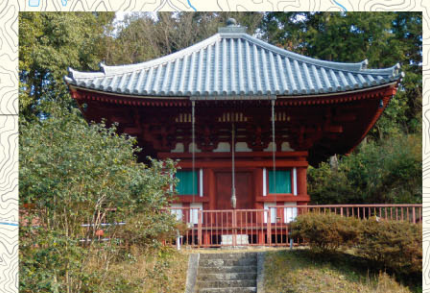
安楽寺塔婆 御所市稲宿の安楽寺の塔婆は元は三重の塔でしたが、今は初層だけが残っています。その上には宝形の屋根があり、塔婆の建築様式から寺は鎌倉時代頃に建てられたと推定されています。
