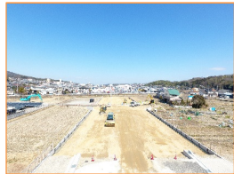
現場状況 (令和4年5月) (擁壁工事実施中)
