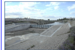
現場状況 (令和4年5月) (西安堵井堰)
