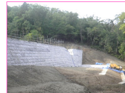
現場状況 (令和4年5月) (堰堤工事実施中)
