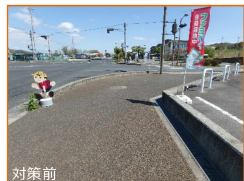
防護柵設置 (令和3年6月対策完了) (国道168号(平群町菊美台1丁目))
