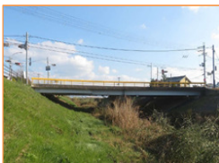
修繕工事実施予定箇所 (大和郡山班鳩線 柳橋) (大和郡山市九条町)
