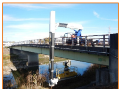
橋梁点検実施状況 (天理班鳩線 高橋) (大和郡山市額田部南町)
