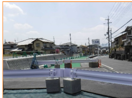
現場状況 (令和4年5月) (道路拡幅実施中)
