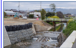
現場状況 (令和4年5月) (護岸整備実施中)
