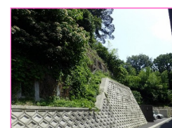
対策予定箇所
