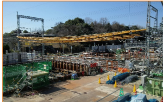
現場状況 (令和4年5月) (近鉄線直下工事中)
