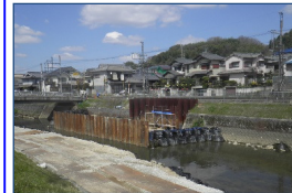
現場状況 (令和4年5月) (上井出井堰工事実施中)
