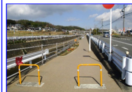
遊歩道 (令和3年11月完成) (富雄川(生駒市上町))
