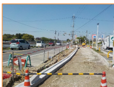
奈良大和郡山斑鳩線 (大和郡山市小泉町) (右折車線整備実施中)
