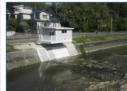
現場状況(令和5年4月) (上井出井堰(令和5年3月完成))
