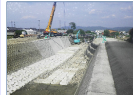
現場状況(令和5年4月) (護岸整備実施中)
