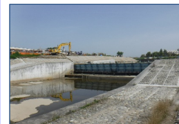
現場状況(令和5年4月) (西安堵井堰)
