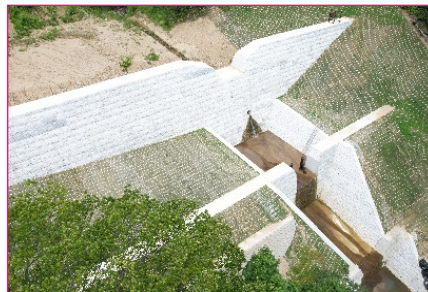
砂防堰堤(令和4年8月完成)
