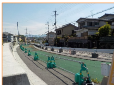
現場状況(令和5年4月) (道路拡幅整備実施中)
