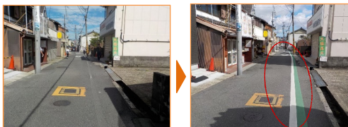
大和郡山上三橋線(大和郡山市高田口町) (令和4年8月完成)
