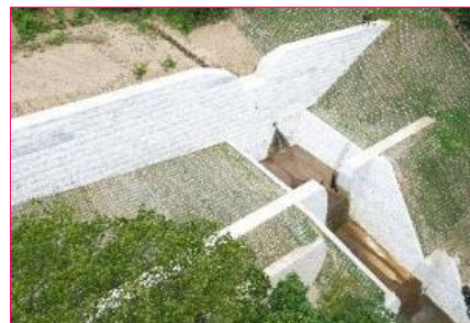
砂防堰堤(令和4年8月完成)
