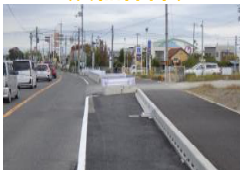
現場状況(令和5年11月) (右折車線整備実施中)
