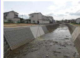
現場状況(令和6年4月) (護岸整備実施中)
