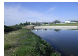
現場状況(令和6年4月) (護岸整備実施中)
