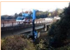
橋梁点検実施状況 (平群信貴山線 信貴山道橋) (平群町福貴)
