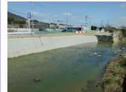
現場状況(R6.3月完成)
