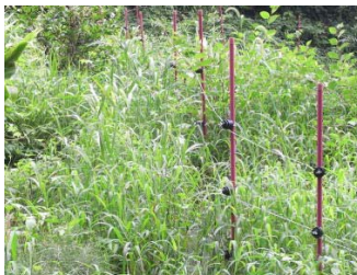
草など電気線に触れ漏電
